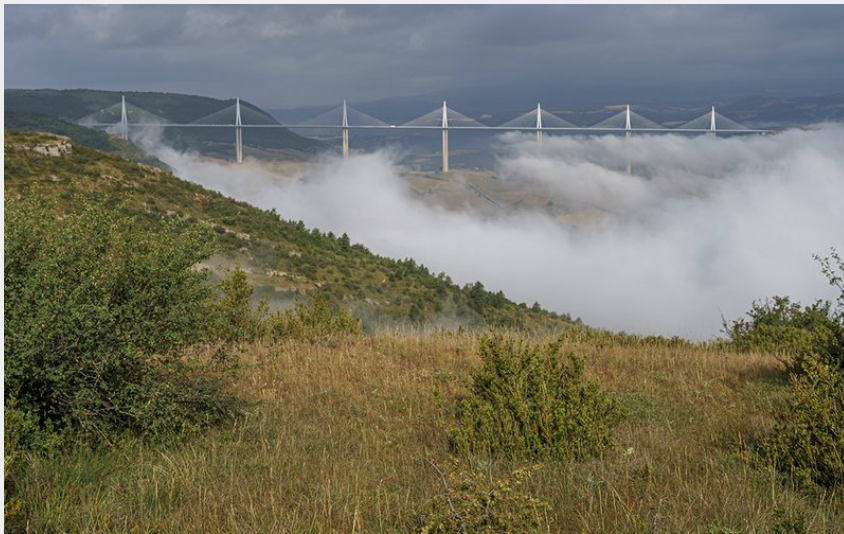
Viaduc depuis Brunas - ©Exo Dams
