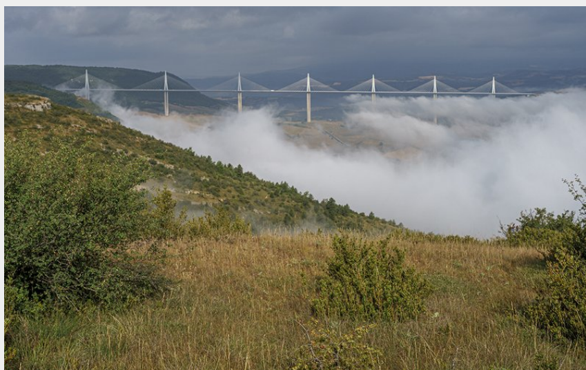
Viaduc depuis Brunas - ©Exo Dams
