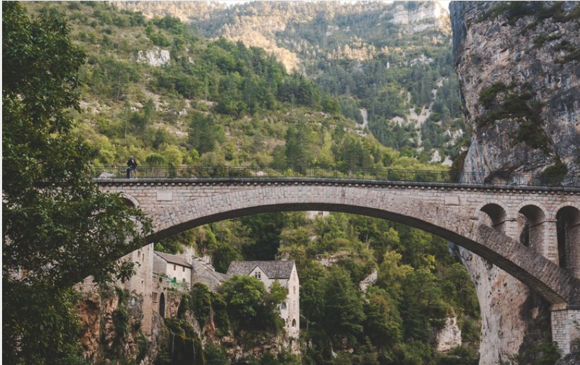
Crédit : Pont de Saint-Chély-du-Tarn (Simon Mioni)
