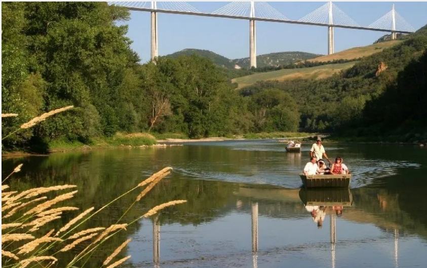
Crédit : Les Bateliers du Viaduc
