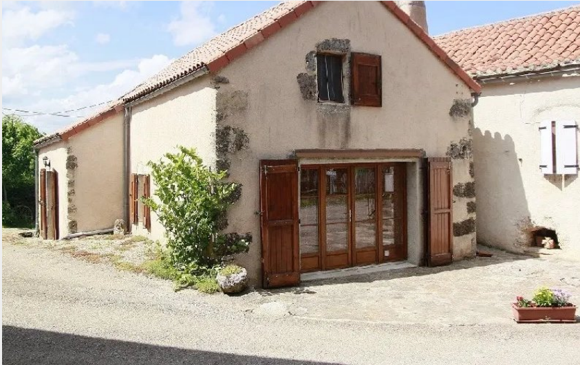
Crédit : Gite du Viaduc (M. Minici)
