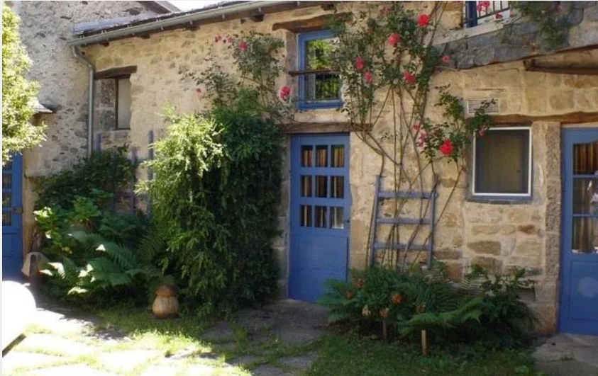
Crédit : Entrée façade Nord sur chambre et mezzanine (AUBERGE LA FABAREDE)
