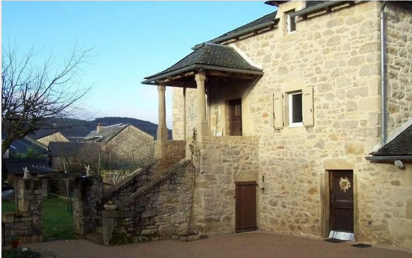
Crédit : Gîte la Petite Maison (Office de Tourisme des Causses à l'Aubrac)
