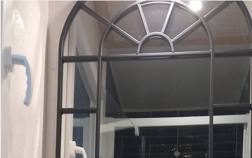
Crédit : salle d'eau (severnes)
