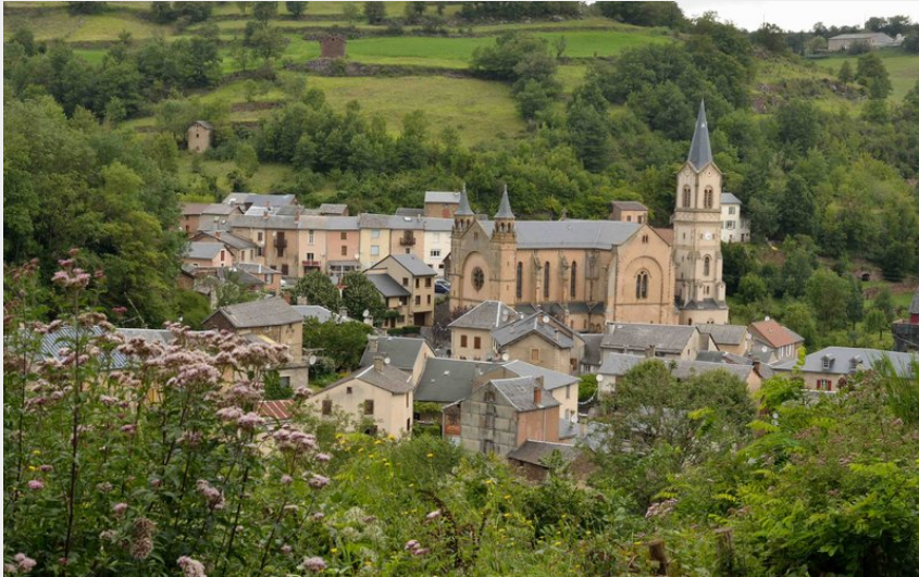
Vue de St Sever (OT RAS)
