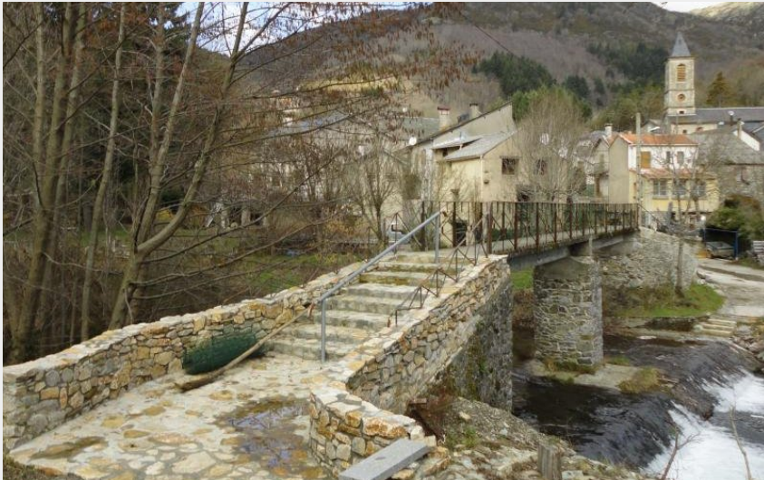
Passerelle du départ (Mairie)
