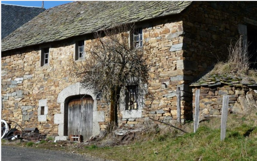
Une grange en très bon état (OT des Pays de Saint-Flour)
