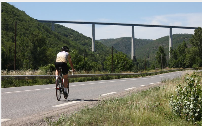
Viaduc de Verrières (@Y.Blanc)
