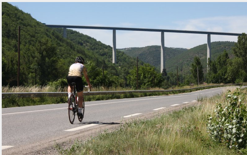
Viaduc de Verrières (@Y.Blanc)
