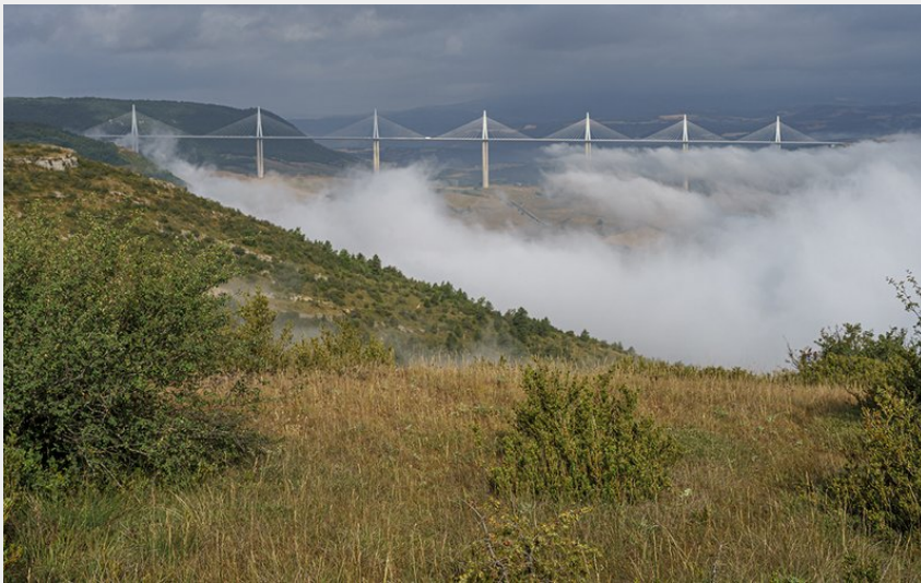
Viaduc depuis Brunas - ©Exo Dams
