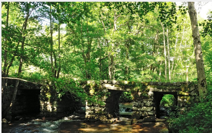
Le pont de Pigasse, construction en orgues basaltiques (A. MÉRAVILLES)
