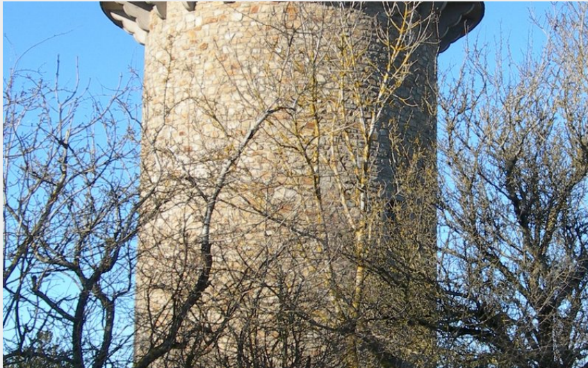
Château d'eau de Curan en pierres de taille (ChristineRousseau)
